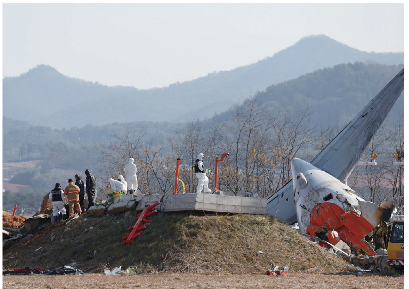
전남 무안국제공항 제주항공 여객기 참사 현장에서 항공·철도사고조사위원회(ARAB) 관계자들이 로컬라이저(방위각 표시 시설)가 설치된 콘크리트 둔덕을 조사하고 있다. /뉴시스
