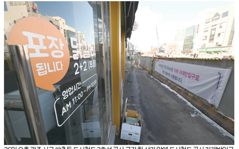
26일 이후 광주 서구 쌍촌동 도시철도 2호선 공사 구간 한상가앞에 도시철도 공사 자재반입구 접근을 막는 철책이 세워져 상인들의 불편을 초래하고 있다. 광주시는 지난 22일 도시철도 2호선 1단계 공사 구간 상부도로 대부분을 개방했지만 일부 구간은 자재반입로 설치 등을 이유로 내년 3월까지 통제한다. /뉴스1
