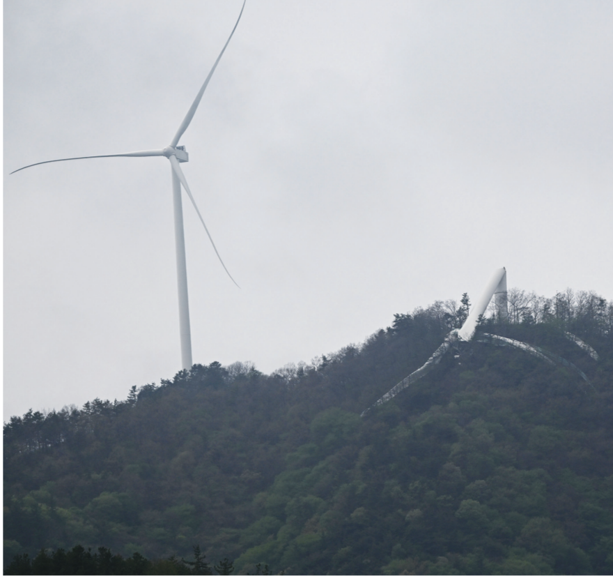
전남 화순군 도암면 우치리 화산산 정상부에 지어진 127m길이의 4.7MW급 풍력발전기가 꺾여있다. 지난 21일 금성산 풍력발전 단지에서 세워진 풍력발전기 11기 중 11번째 발전기가 쓰러진 것과 관련해 사고의 시공·제조사 관계자들이 사고 원인을 밝히기 위해 현장 조사를 진행하고 있다.
