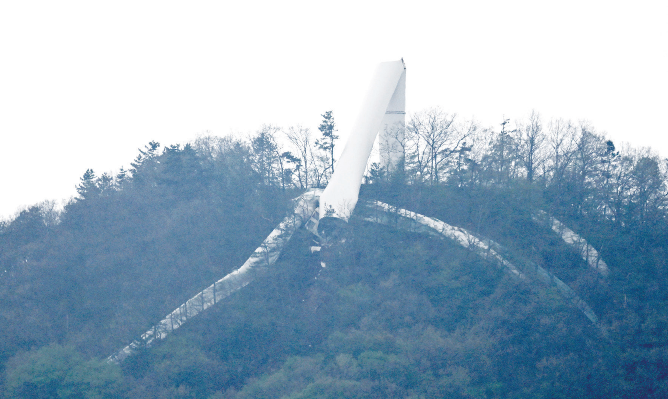
23일 오후 전남화순군 도암면 우치리 화향산 정상부에 지어진 127m길이의 4.7MW급 풍력발전기가 꺾여있다. 지난 21일 금성산 풍력발전 단지에 세워진 풍력발전기 11기 중 11번째 발전기가 쓰러진 것과 관련해 사고의 시공·제조사 관계자들이 사고 원인을 밝히기 위해 현장 조사를 진행하고 있다. /뉴시스
