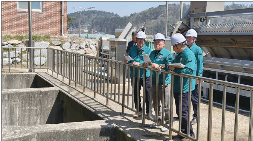
영광군, 여름철 자연재난 대비 배수펌프장 등 현장점검
