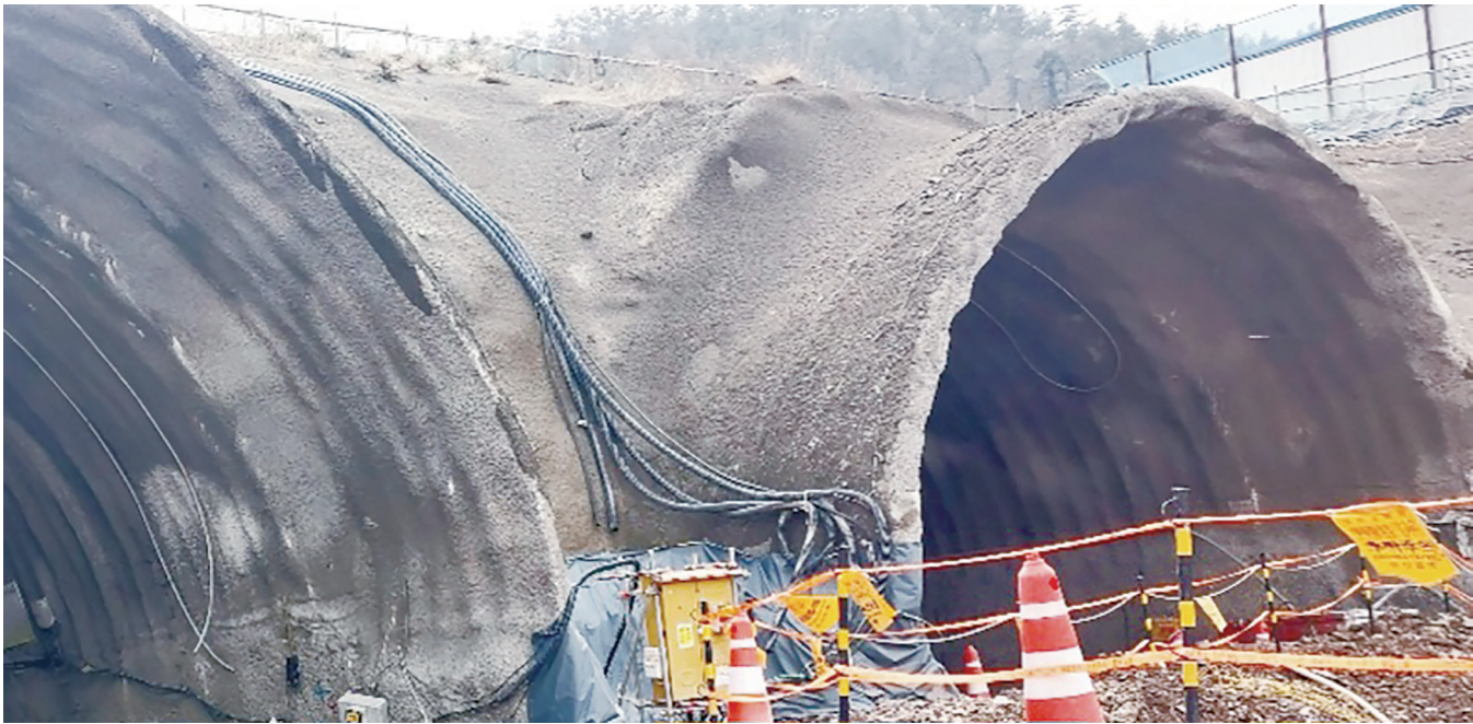
국도 77호선 1공구 달동 터널공사 현장
