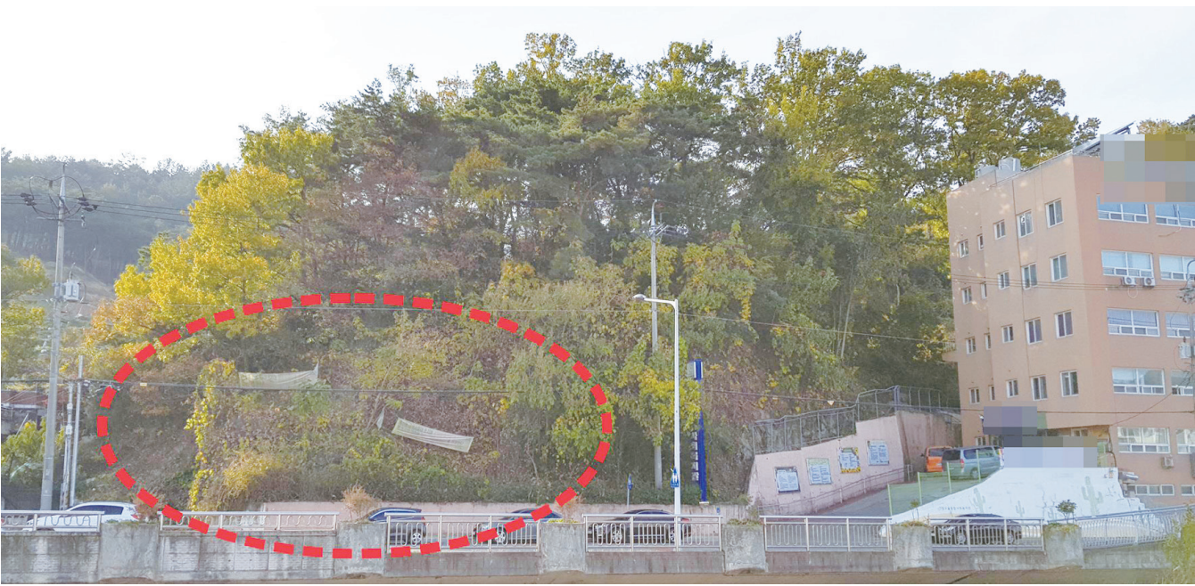
광주 동부경찰서신축이전부지진입로가들어설예정인암반지대. 빨간색부분은암반제거공사가이뤄질것으로예상되는구역. 사진=A사회복지관탄원서갈무리
